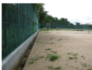
雨水貯留施設 (周田小堤)
