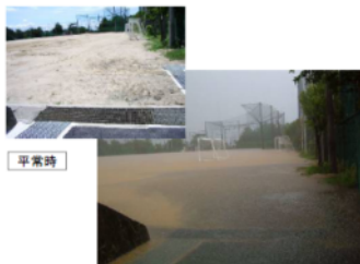
雨水貯留状況 (大雨時)
