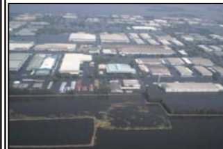
平成23年10月 タイ・チャオプラヤ川の氾濫によるロジャナ工業団地浸水状況
