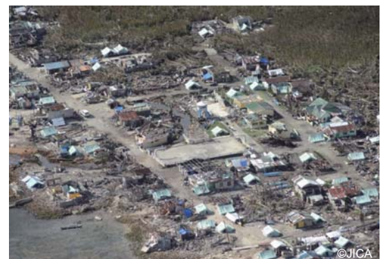
ギゴソ周辺の被害状況 ©JICA
