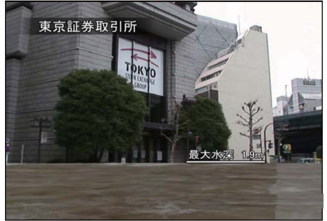
東京証券取引所 浸水状況(荒川破堤シミュレーション結果)
