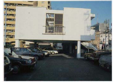
1階部分をピロティ(高床構造)とすることで浸水時の被害を軽減
