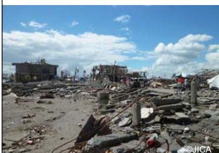
パロ~タクロバン空港にかけての被災状況 ©JICA
