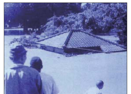
被災地域の状況(埼玉県川口市)
