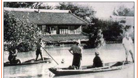
被災地域の状況(埼玉県川口市)
