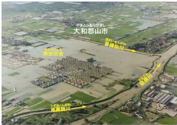
大和郡山市 稗田団地の浸水状況 (佐保川5.0k付近)
