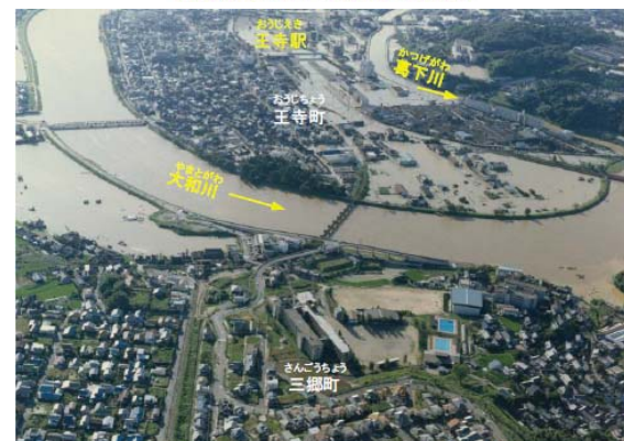
王寺町 葛下川合流点の浸水状況 (大和川27.0k付近)
