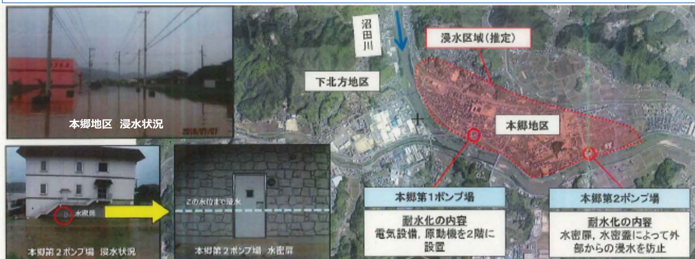
平成30年7月豪雨において河川氾濫によりポンプ場が浸水したが、耐水化により排水機能を確保。排水ポンプの継続運転によって約90万m 3 の湛水を排除し、本郷地区の早期復旧に貢献した事例 (広島県三原市)
