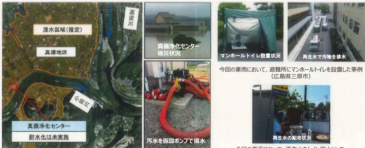
今回の豪雨において河川氾濫により下水処理場が浸水し機能停止したが、被災後3日後には最低限の下水処理機能を確保した事例。(岡山県倉敷市)
