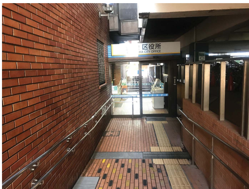
葛飾区区役所新館1階入口（昭和53（1978）年建築）
