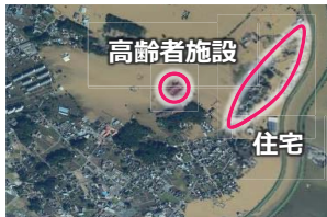
【川越市下小坂地区の被災状況】
