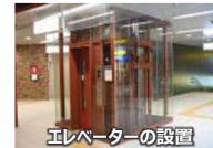
エレベーターの設置
