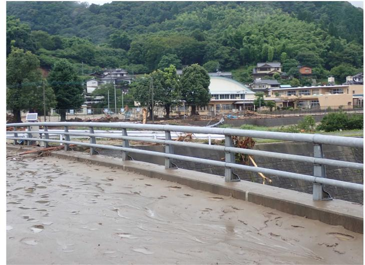
小川橋桁上の土砂堆積（～10cm程度堆積）
