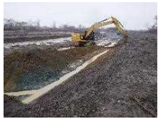
河道掘削 (石狩川水系、北海道開発局)
