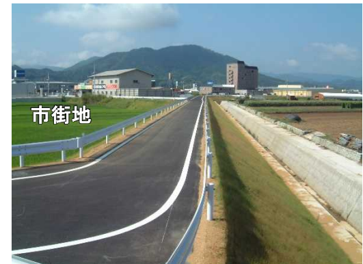
二線堤整備状況
