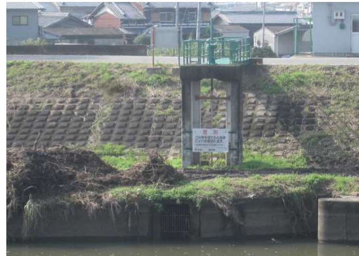
大和川に設置されている取水樋門
