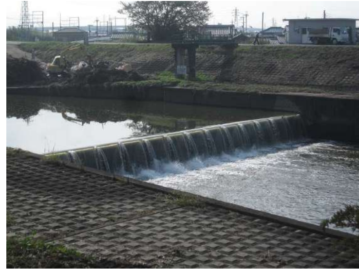
大和川に設置されている井堰(自動転倒)
