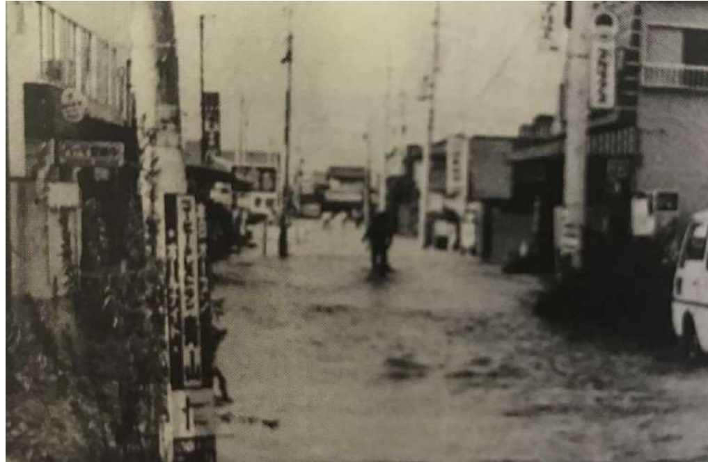
浸水した結崎駅周辺(昭和57年8月)
