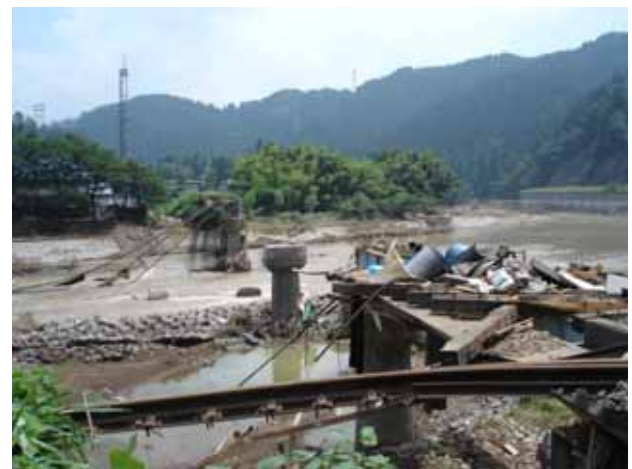
Fig. 6 Collapsed RB 1
