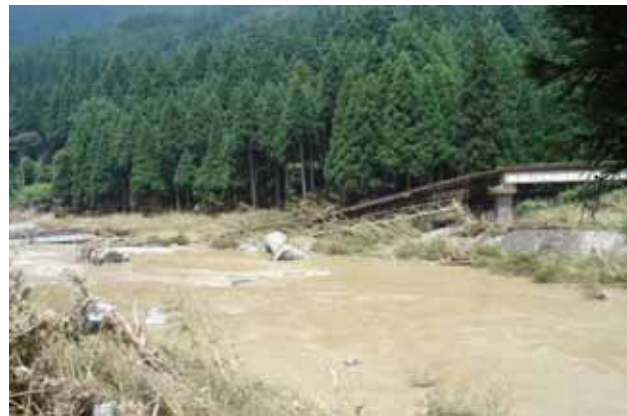
Fig. 8 Collapsed RB 3
