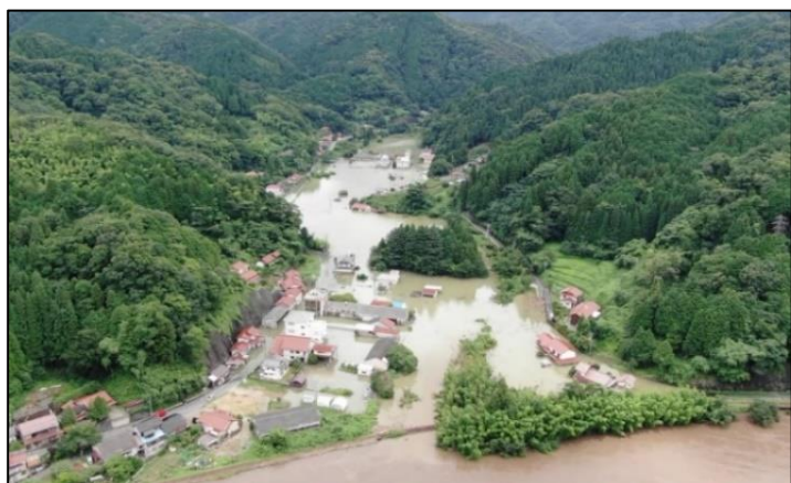
令和2年7月豪雨 (バックウォーター)
