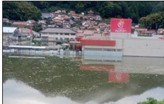
⑥令和3年8月 (内水氾濫により商業施設等に浸水) 〈因原地区〉
