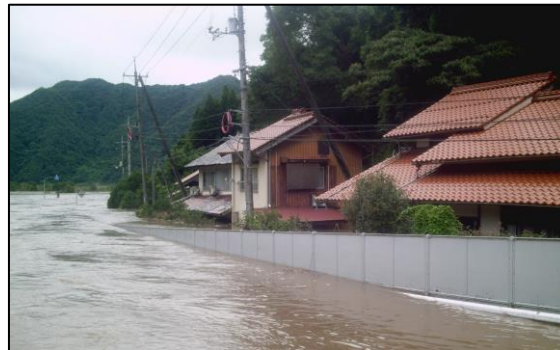
④平成30年7月 (国道261号が冠水〈瀬尻・久料谷地区〉)
