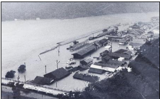
②昭和47年7月 (旧JR三江線石見川本駅付近が完全に水没)
